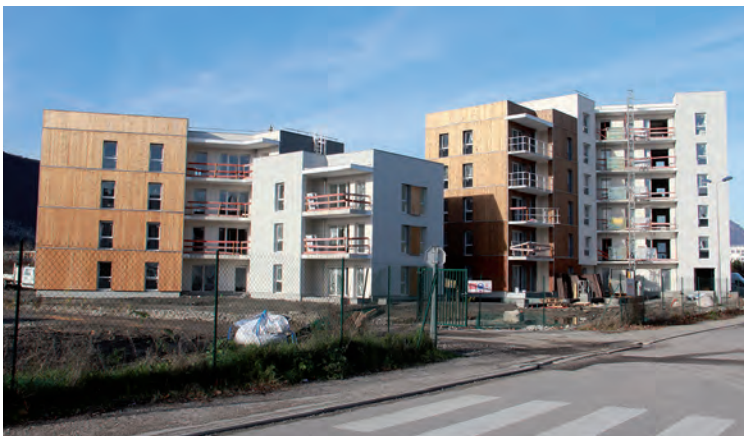
En quelques années, la physionomie de Pont de Claix a fortement évolué, comme en témoignent les nouvelles constructions dans le secteur des 120 Toises.
