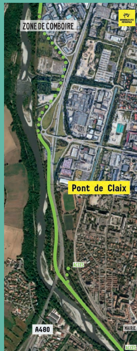
En pointillés la zone en travaux.
